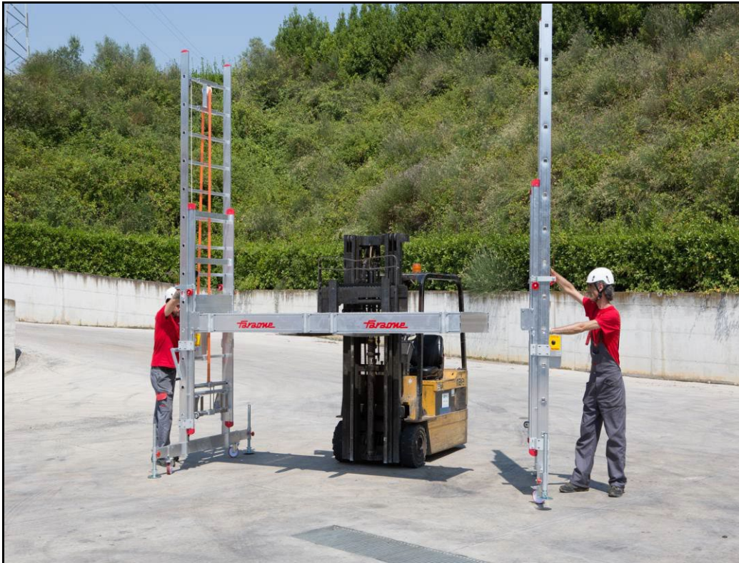
Rys.3: Wsuwanie podestu do dwóch boków rusztowania
