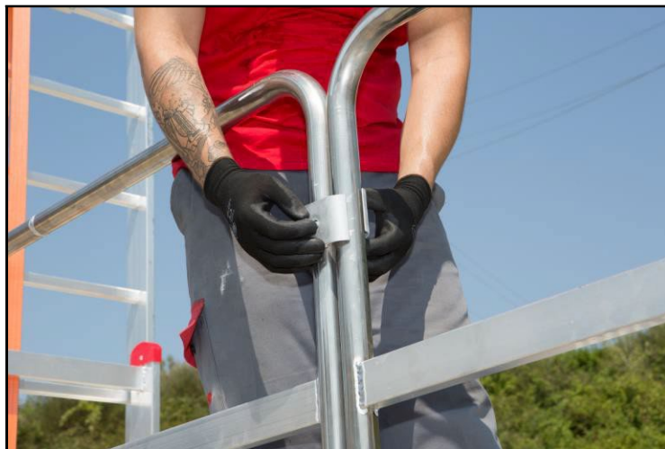
Rys. 7: Montaż barierek jedna do drugiej
